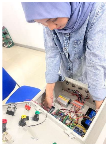
Gambar 4.11 Peletakan Komponen ke dalam Panel Box
