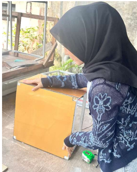
Gambar 4. 3 Pemasangan alas Greenhouse
