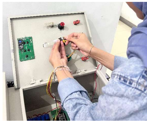
Gambar 4.13 Pemasangan Keypad pada Sisi Depan Panel Box
