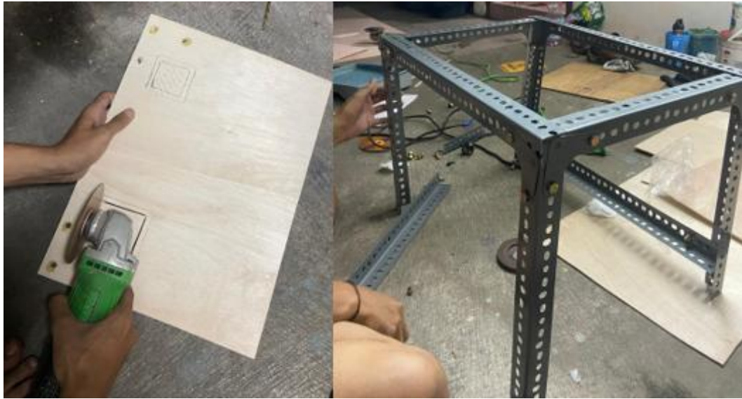
Gambar 4. 5 Perakitan dan Pemasangan Rangka Kandang
