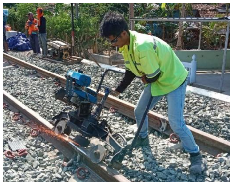
Gambar 2.3 Mesin gerinda Matisa MP12 Sumber: dokumentasi penulis
