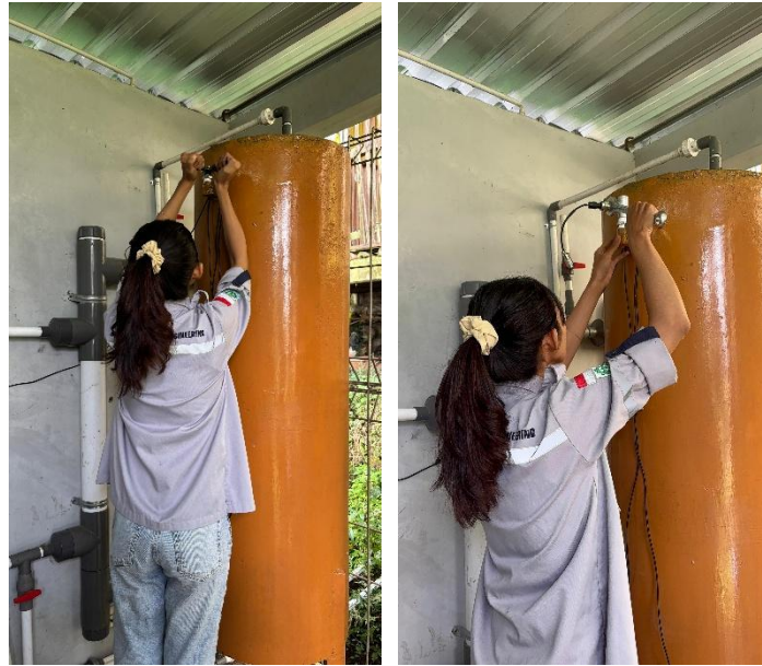
Gambar 4. 19 Pemasangan Sensor Pressure Pada Tabung Gas Rawa
