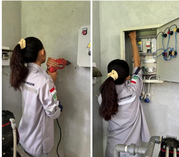
Gambar 4. 17 Pemasangan Box Panel Kontrol
