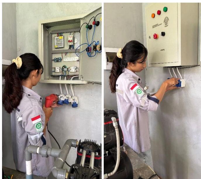
Gambar 4. 18 Pemasangan Stop Kontak MCB
