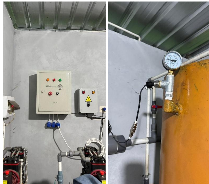
Gambar 4. 20 (a) Panel Box Kontrol Yang Telah Terpasang (b) Sensor Pressure Yang Telah Terpasang
