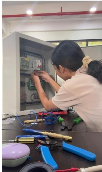
Gambar 4. 6 Pemasangan Pengkawatan Box Panel
