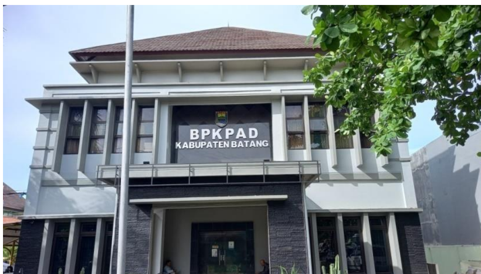
Gambar 2. 1 Kantor BPKPAD Kabupaten Batang
