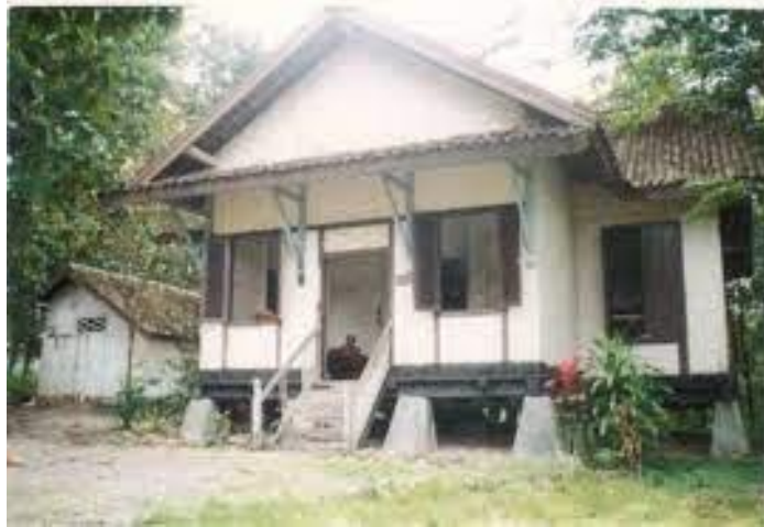
Gambar 2.29 Rumah Panggung Struktur Umpak
