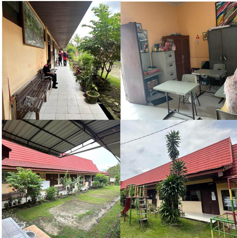
Gambar 3. 3 Dokumentasi Bangunan SLB Sri Mujinab Sumber: Penulis, 2024
