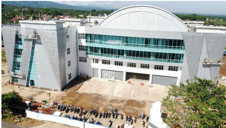
Gambar 8. Tampak Perspektif Existing Gedung STP
