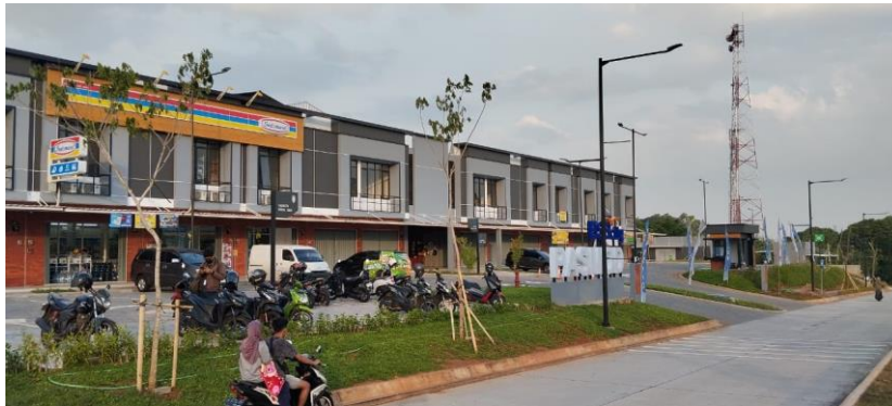
Gambar 2. 52 Bangunan Pasar Modern BSB Kota Semarang
