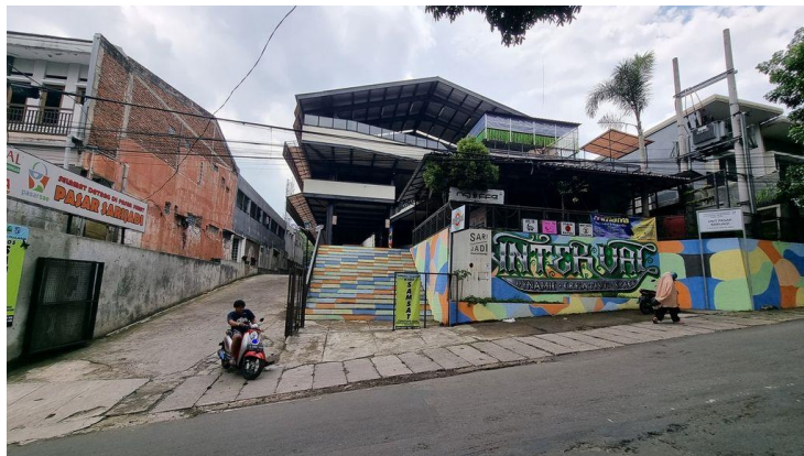
Gambar 2. 45 Bangunan Pasar Sarijadi Bandung
