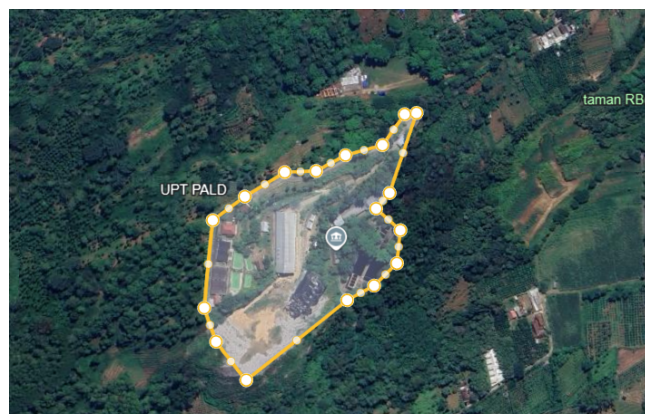
Gambar 3.15 Tapak TPA Tlekung
