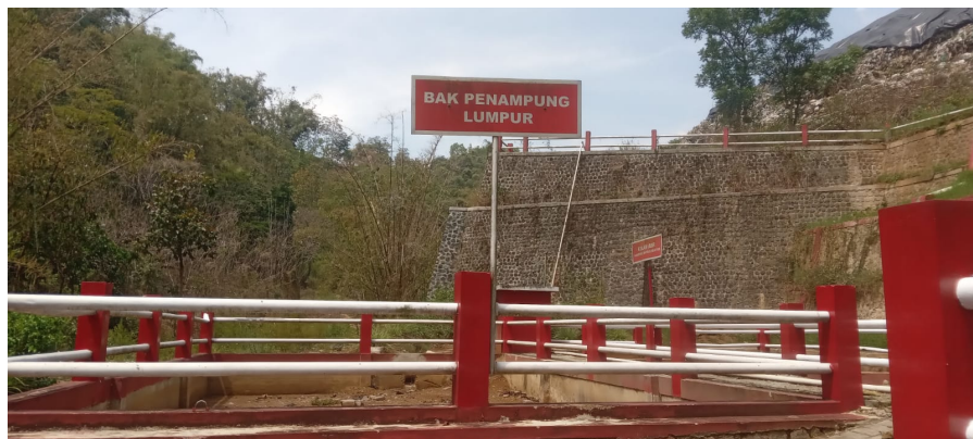
Gambar 3.14 Bak Penampung Lumpur TPA Tlekung
