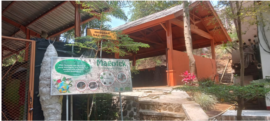
Gambar 3.10 Hanggar Gas Metana TPA Tlekung
