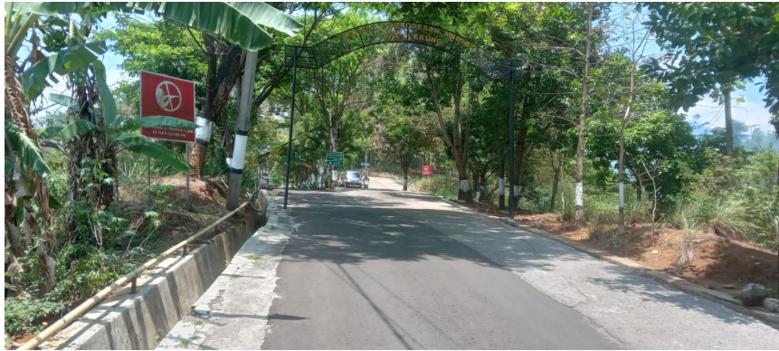
Gambar 3.3 Pintu Gerbang TPA Tlekung
