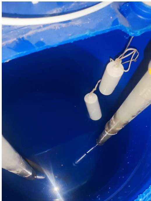
Gambar 5.8 Pengaturan level pelampung
