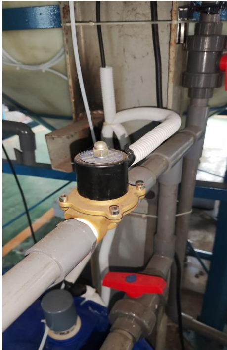
Gambar 4.5 Pemasangan solenoid valve
