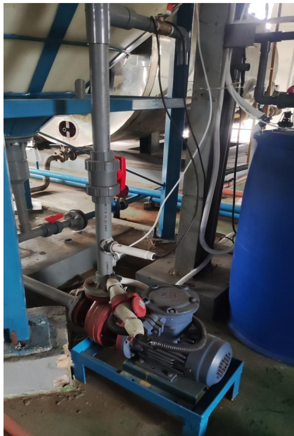
Gambar 4.3 Pemasangan sensor pH
