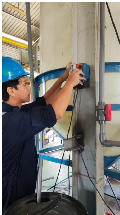
Gambar 4.4 Pemasangan dosing pump
