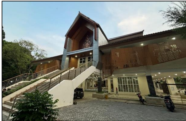
Gambar 3.14. Gedung Teater TBRS Sumber : Dokumentasi Pribadi, 2024
