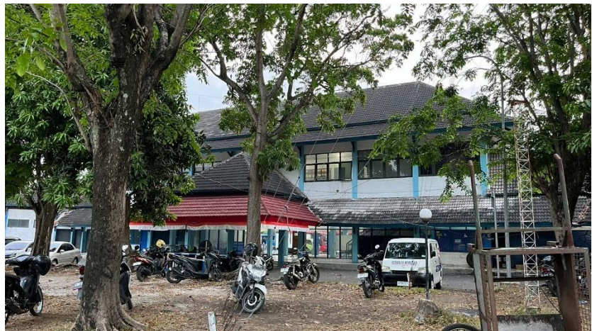
Gambar 36. Tampak bangunan eksisting Terminal Penggaron
