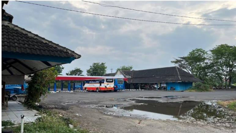
Gambar 38 Kondisi eksisting ruang parkir bus di Terminal Penggaron
