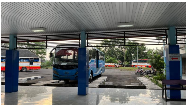
Gambar 39 Ruang parkir dan peron pengangkutan penumpang di Terminal Penggaron
