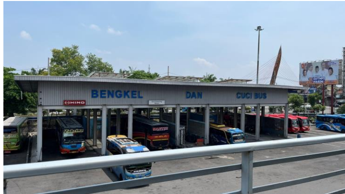
Gambar 18 Ruang bengkel dan cuci bus pada area pelataran parkir bus
