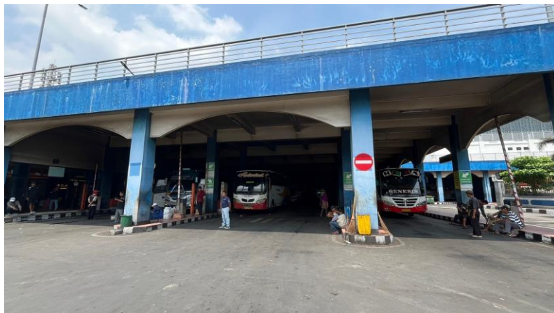
Gambar 11 Jalur keberangkatan bus sisi timur Terminal Tirtonadi
