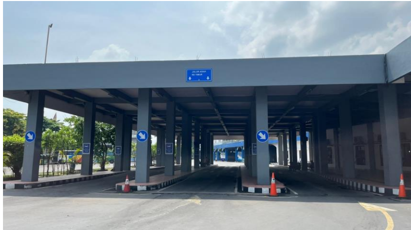
Gambar 12 Jalur kedatangan penumpang menuju terminal sisi timur
