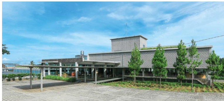
Gambar 2.3 Tampak depan Rumah Atsiri (dokumentasi oleh : Construction+)
