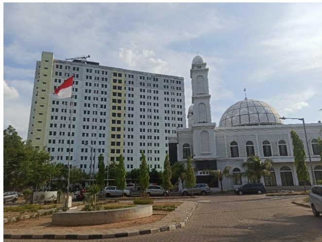
Gambar 2. 3 Rusun Tower Rawa Bebek Sumber : Google Images, 2024
