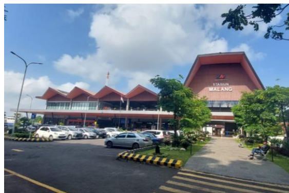
Gambar 2.4 Stasiun Kotabaru Malang (Sumber: Dokumentasi pribadi)
