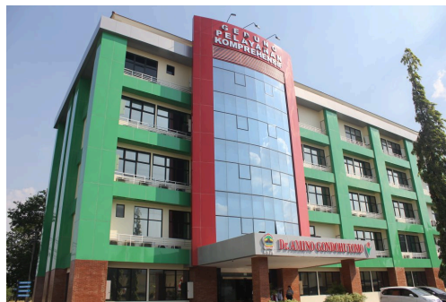
Gambar 2.4 Gedung Pelayanan Komprehensif
