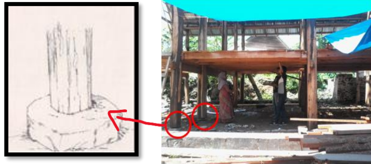
Gambar II.15 Pemasangan Pondasi Umpak
