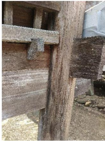
Gambar II.12 Detail 1 Sambungan Pasak Pada Rumah Gadang
