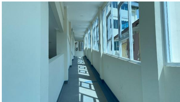
Gambar 2.10 Ramp Evakuasi RSUD dr. Gunawan Mangunkusumo Sumber: Dokumentasi Pribadi, 2024
