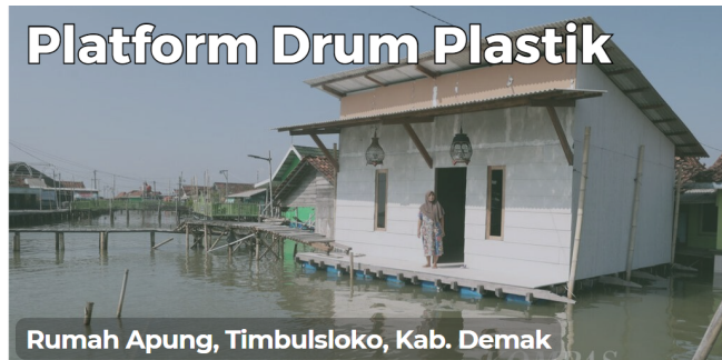
Gambar 2.2 Bangunan Apung dengan Platform Drum Plastik
