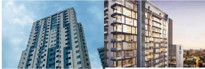
Gambar II. 24 Apartemen Precast Warna gelap dan Apartemen material kaca terang
