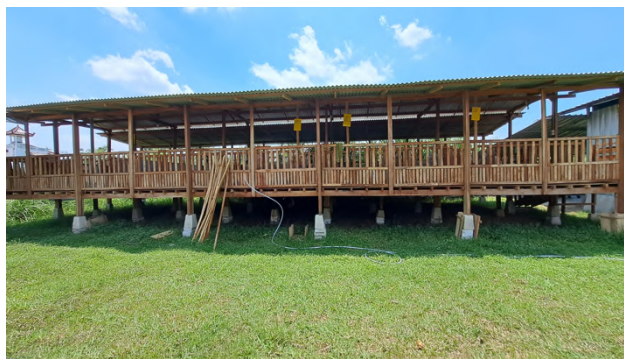
Gambar 2. 8 Amar Farm Sumber : Dokumentasi Penulis
