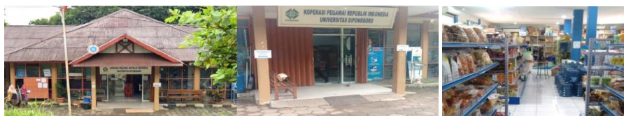
Gambar 3. 4 Kondisi Gedung KPRI Undip (Sumber: Studi Kelayakan Pembangunan Gedung Undip)
