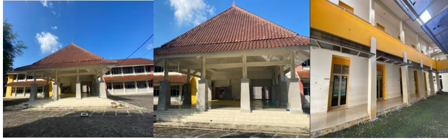
Gambar 3. 7 Kondisi Gedung Student Center (Sumber: Studi Kelayakan Pembangunan Gedung Undip)
