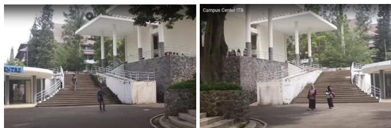
Gambar 2. 17 Gedung Barat dan Timur ITB Campus Center (Sumber : www.itb.ac.id )
