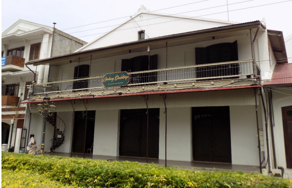
Gambar 2.5 Gedung Oudetrap 2 Lantai (Luar)
