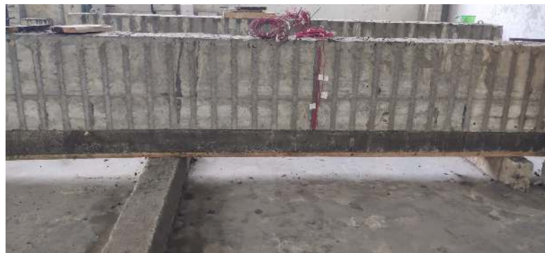
Gambar 3.30. Hasil pengecoran beton geopolimer pada balok beton perkuatan
