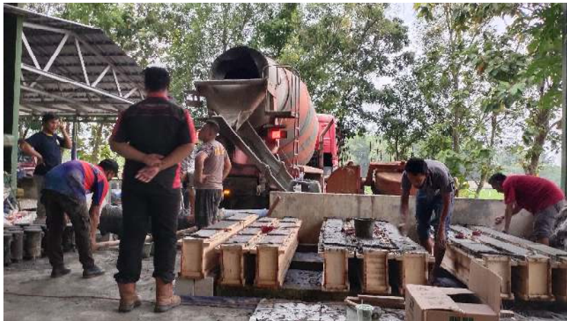
Gambar 3.23. Pelaksanaan pengecoran balok
