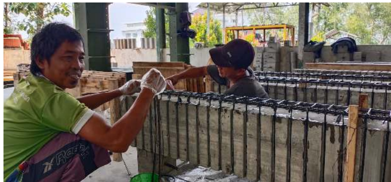
Gambar 3.29. Pemasangan tulangan perkuatan CFRP string
