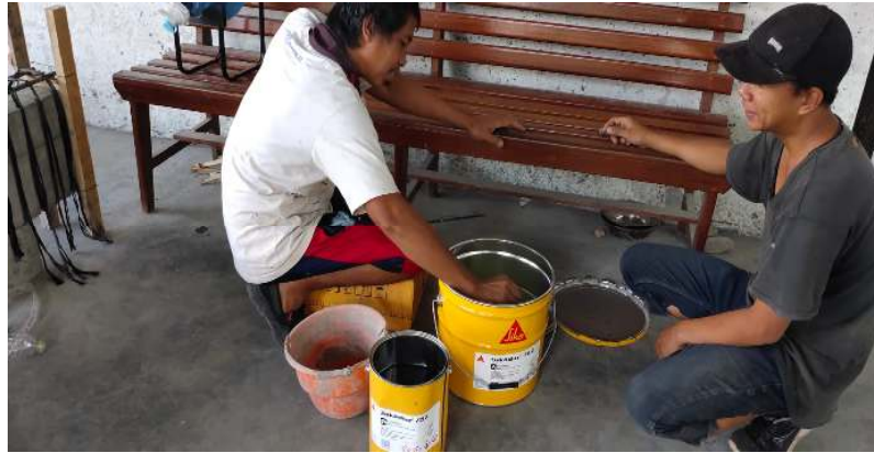
Gambar 3.28. Proses pencampuran resin sikadur 752
