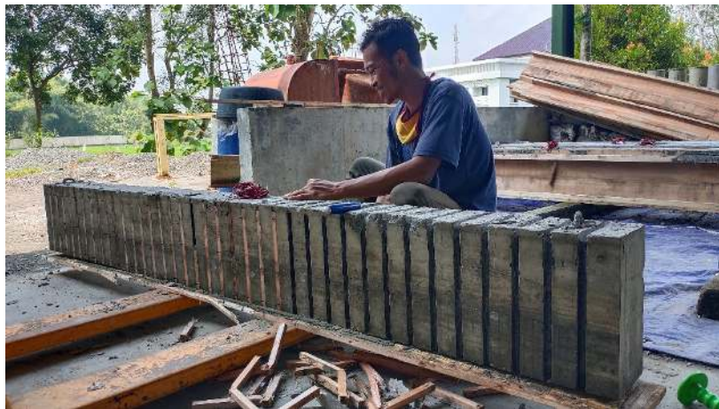
Gambar 3.25. Proses pembuatan alur pada balok perkuatan
