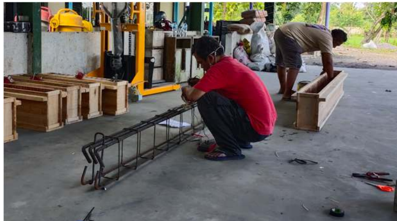
Gambar 3.21. Setting penulangan balok tanpa perkuatan
