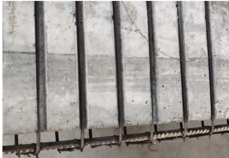
Gambar 3.27. Pemasangan baja tulangan perkuatan pada balok BGS
