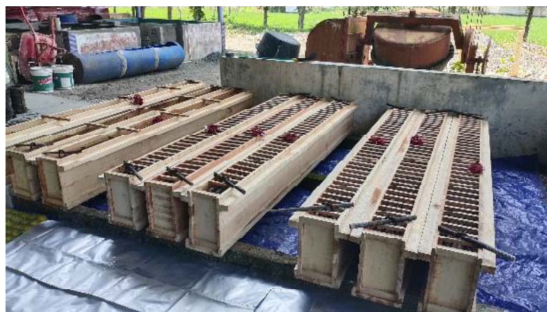
Gambar 3.22. Bekisting balok
