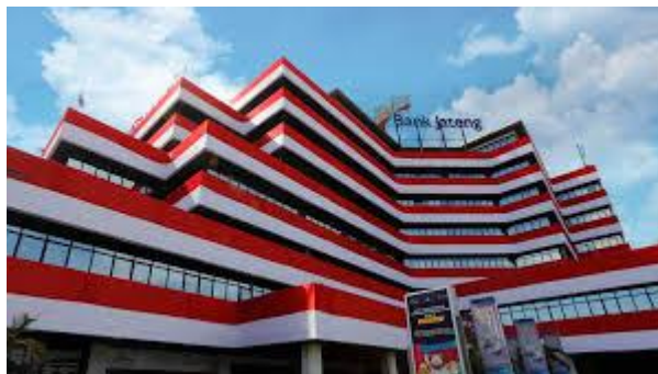
Gambar 2. 1 Gedung Bank Jateng
