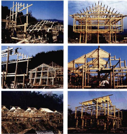
Gambar 2.3 Proses Pembangunan Rumah Panggung (Yang, 2014)
