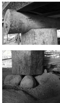
Gambar 2.22. Detail Struktur Lapis Bawah Lamban Tuha Sumber : Iwan Murawan Ibnu
