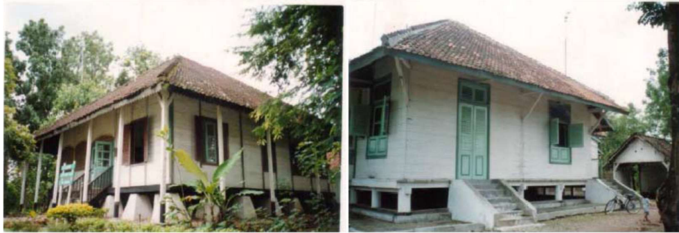
Gambar 2.4 Tipe Tiang Bangunan Panggung (kiri -umpak, kanan-ceblokan) (Sukawi, 2009).
