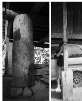
Gambar 2.23. Tipe Tiang Kolong Sumber : Iwan Murawan Ibnu
