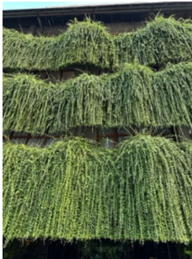
Gambar 2. 38 Fasad dengan vegetasi bagian depan entrance
