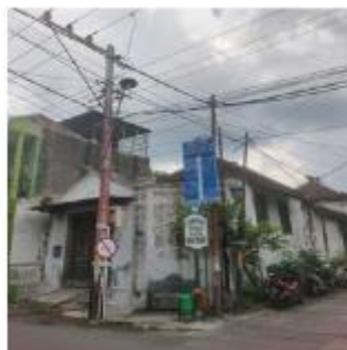
Kabel listrik yang tak teratur membuat polusi visual.
