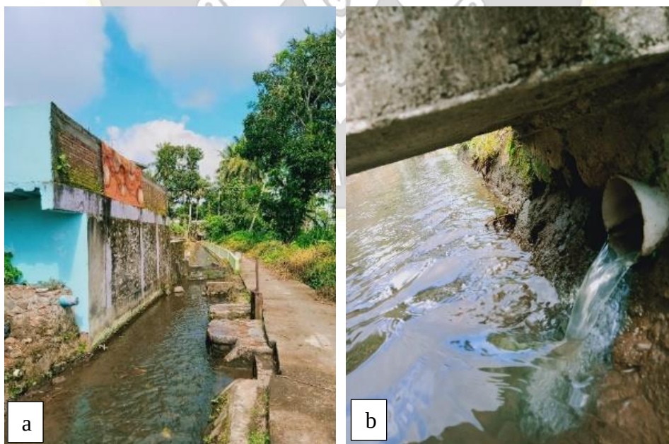
Gambar 1. Letak IPAL Komunal Guyub Rukun di Sekitar Sungai Cengek, (b) Pipa Outlet Mengalirkan Effluent ke Sungai Cengek
