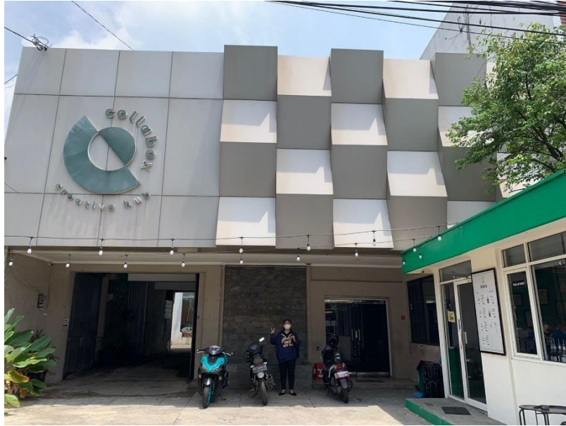
Gambar 2.9 Fasad Collabox Creative Hub (Sumber: Dokumentasi Penulis)
