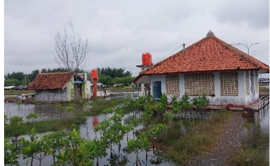
Gambar 2.6.2 Toilet Umum dan Mushola
