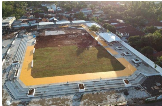
Gambar 1.4 Pembangunan RTH di Boja
