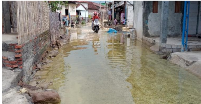
Gambar 9 Potret Akses Jalan yang tergenang banjir rob
