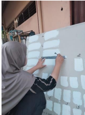
Gambar 3.63 Mengukur Luas Area Pengecatan
