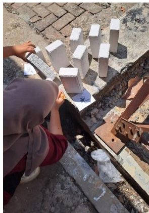
Gambar 3.48 Mengecat Paving Block
