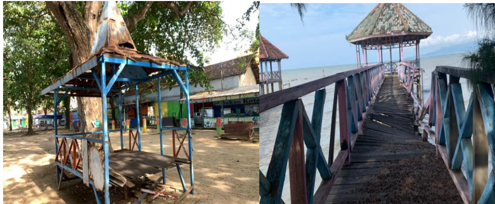
Gambar 1. 3 Fasilitas Umum Rusak
