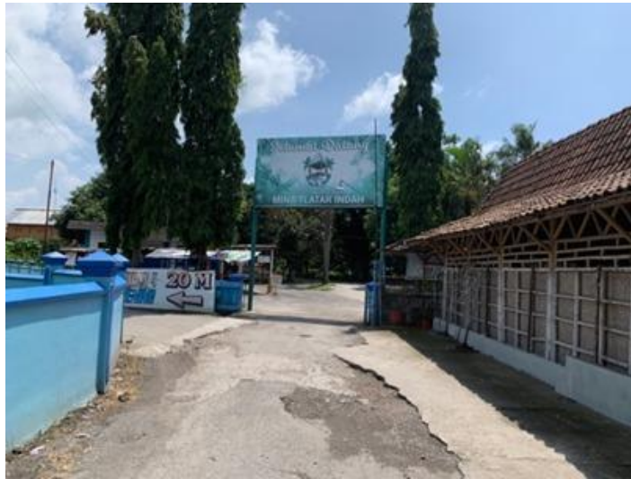
Gambar 1. 1 Jalan Taman Air Tlatar
