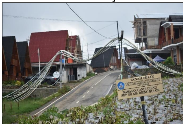
Gambar 1.8 Kondisi Pipa Paralon Melintang di Objek Wisata Candi Arjuna
