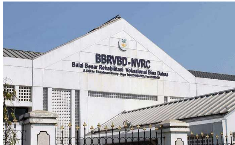
Gambar 2. 9 Balai Besar Rehabilitasi Vokasional Bina Daksa, Cibinong
