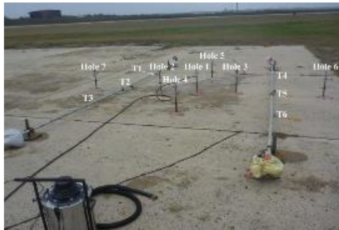
Gambar 2.11 Injeksi grouting pada tanah dasar di bawah perkerasan kaku Bandara Magong Penghu (Ni and Cheng, 2012).
