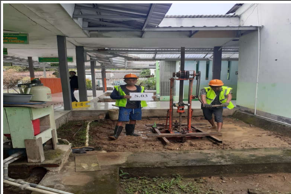
GAMBAR KEGIATAN PENELITIAN TANAH PEKERJAAN PEMBANGUNAN RUMAH SAKIT UMUM AN NI'MAH WANGON JALAN RAYA WANGON Ci, Klapagading, Kecamatan Wangon Kabupaten Banyumas - Jawa Tengah
