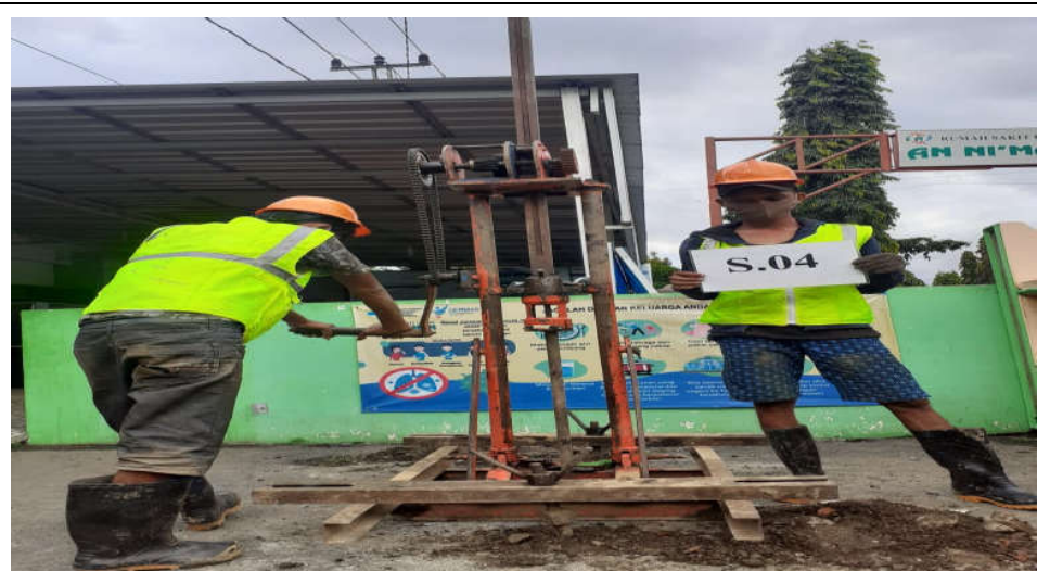
GAMBAR KEGIATAN PENELITIAN TANAH PEKERJAAN PEMBANGUNAN RUMAH SAKIT UMUM AN NI'MAH WANGON JALAN RAYA WANGON Ci, Klapagading, Kecamatan Wangon Kabupaten Banyumas - Jawa Tengah
