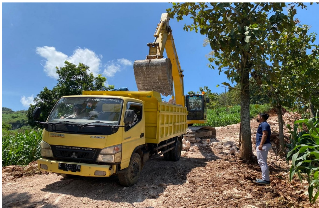
Site Visit Akses Jalan Usaha Tani
