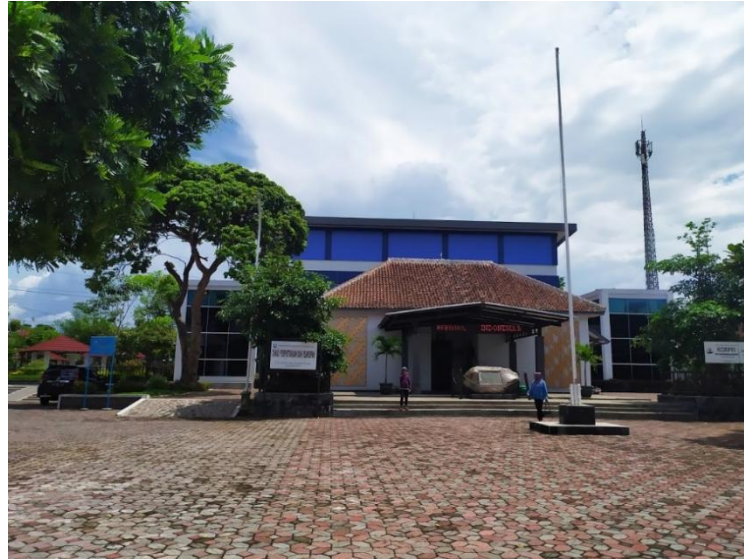
Gambar 2.2 Tampak Depan Gedung Dispupa Kab. Magelang
