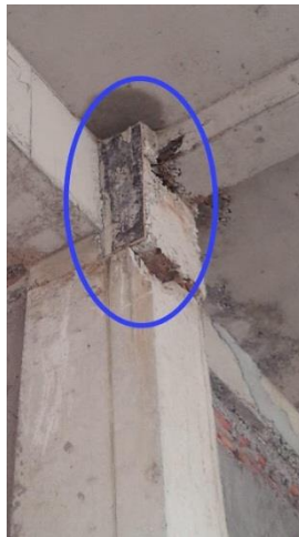
Gambar 1.2 Hasil Pengecoran Kolom C1 yang keropos
