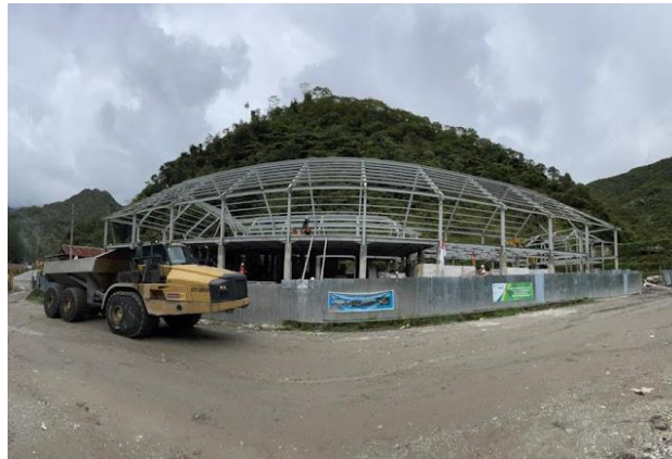
Gambar 9 Pembangunan Rumah Sakit Umum Daerah (RSUD) di Kampung Waa-Banti
