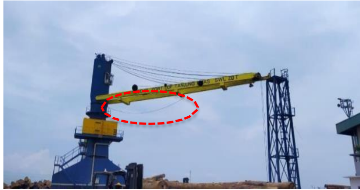
Gambar 1. 2 Kondisi terjadinya kerusakan alat pada crane Sumber: Laporan Kegiatan Dermaga Pelabuhan Dalam, 2023
