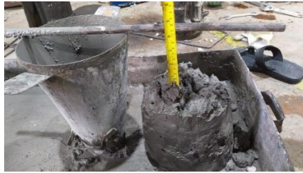
Gambar 3.33 Proses Pengukuran Hasil Uji Slump
